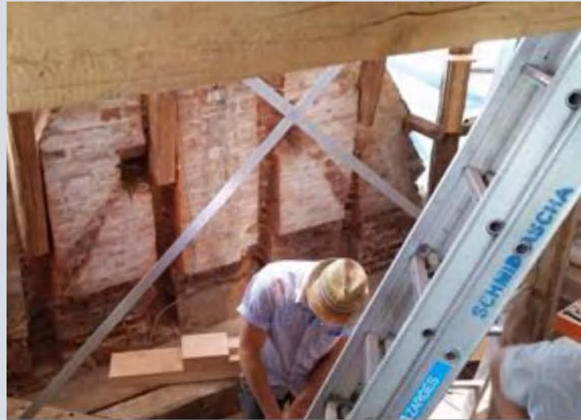
Sanierung der historischen Holzdachstuhl
