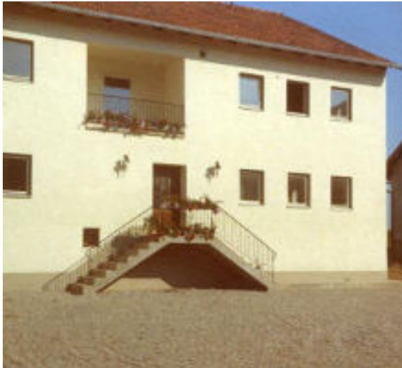
Sternhof nach dem Umbau
