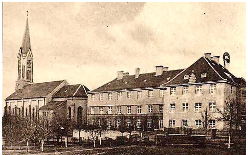
Südflügel: Mitte, Bau von 1861/62, Aufstockung 1931. Rechts: Neubau 1930/31
