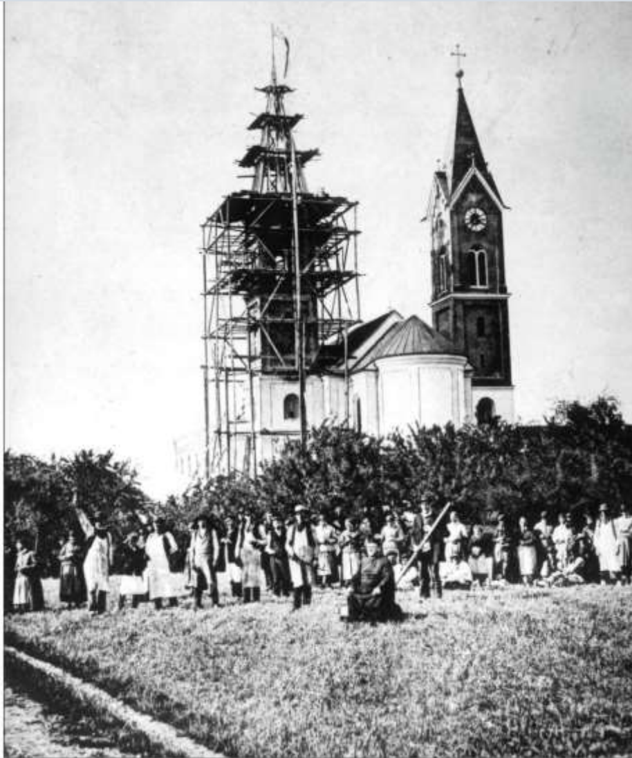
Fotografie Maria Hilf während der Bauphase des zweiten Turms von Südosten mit Wallfahrtsdirektor Ignaz Berger (Heimatverein Vilsbiburg)
