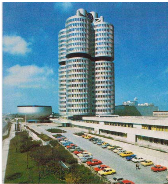
157.1 Blick auf das extravagante Verwaltungsgebäude eines Automobilherstellers in München
