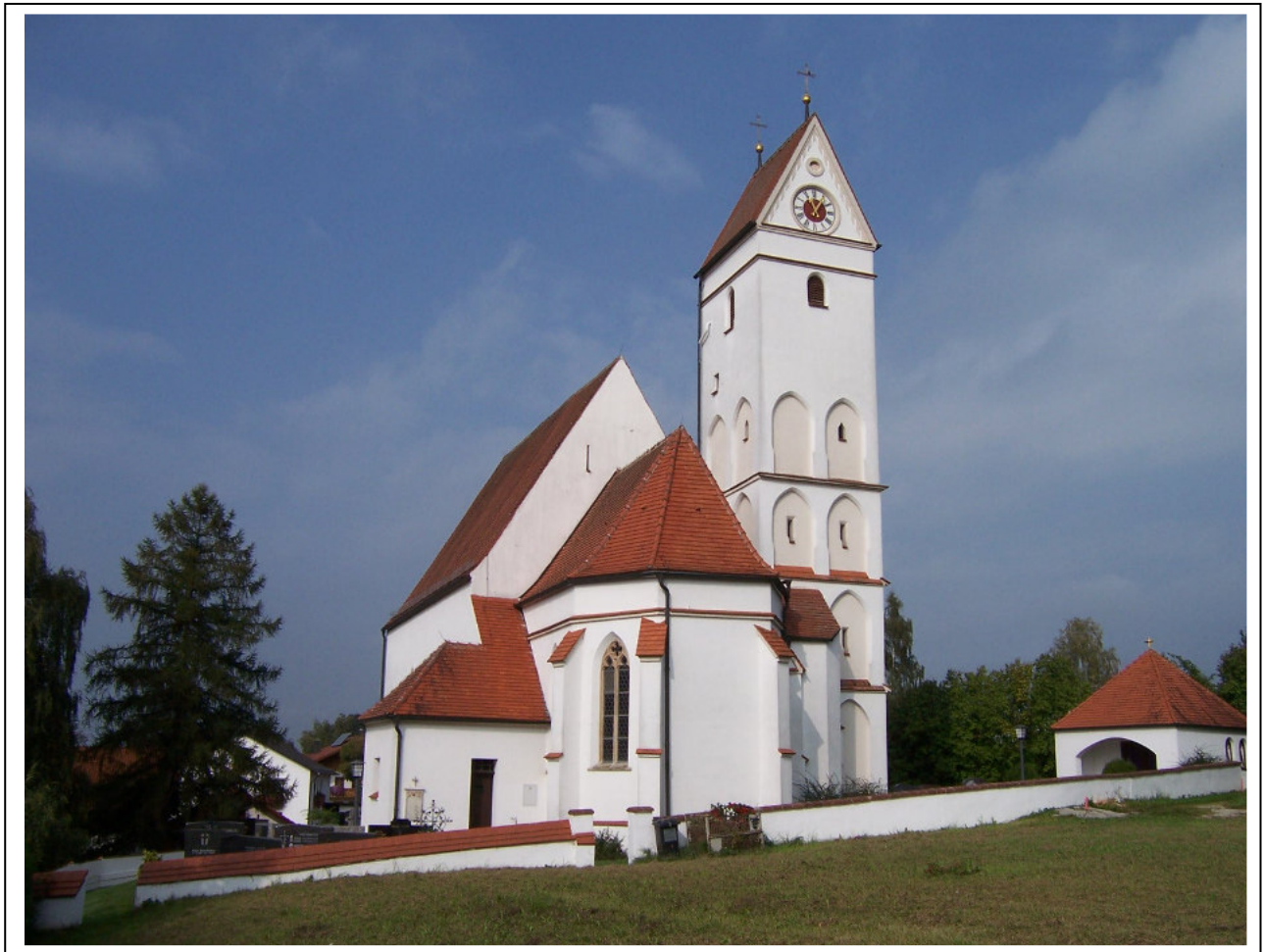
| Filialkirche Frauensattling von Südosten, mit Sakristei, Friedhofmauer, Leichenhaus und Friedhoferweiterung.
